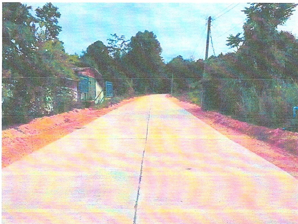
โครงการก่อสร้างถนนคอนกรีตเสริมเหล็ก สายทางนายอบ-นางจิตร พท.ถ.58-023 หมู่ที่ 10 กว้าง 5 ม. ยาว 115 ม. หิน 0.15 ม.หรือมีพื้นที่ไม่น้อยกว่า 575 ตารางเมตร ไหล่ทางข้างละ 0.50 ม.
